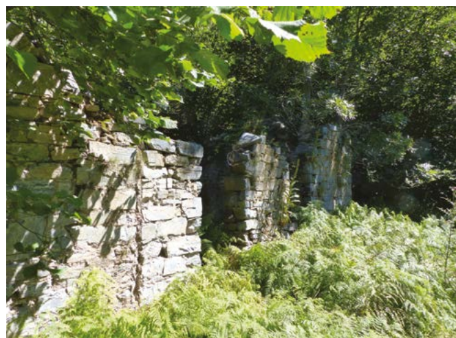
Ruinas de la casa de los mineros. Foto: X. Rodríguez.
