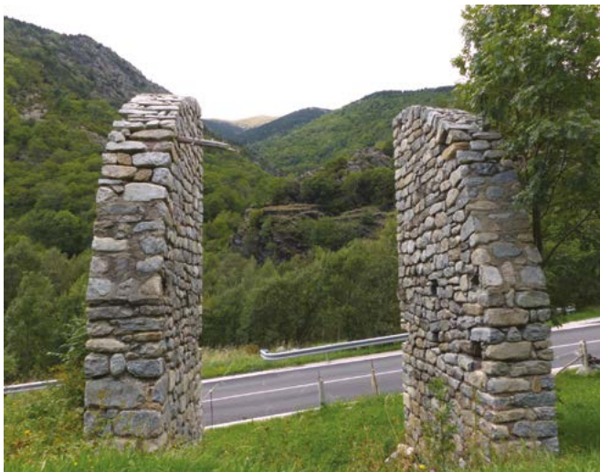
Restos de la estación inferior del cable, a pie de carretera. Foto: X. Rodríguez.
