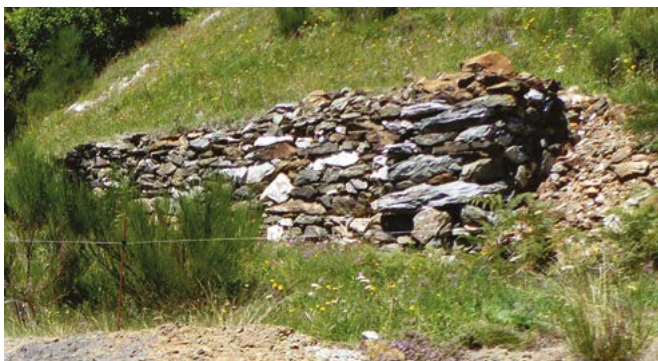
Restos de la estación superior del cable. Foto: X. Rodríguez.
