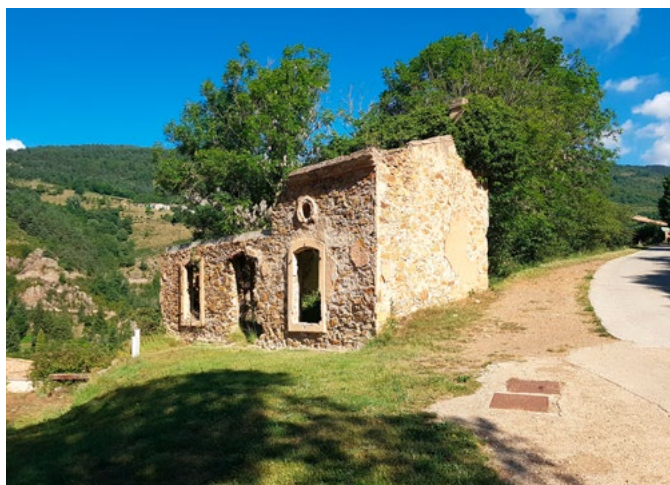
Fig. 6. Casa de la mina, l'any 2017. Foto: Xavier Rodríguez.
